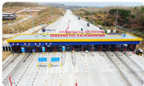
Gerbang Tol Kalikangkung Jalan Tol Batang-Semarang
